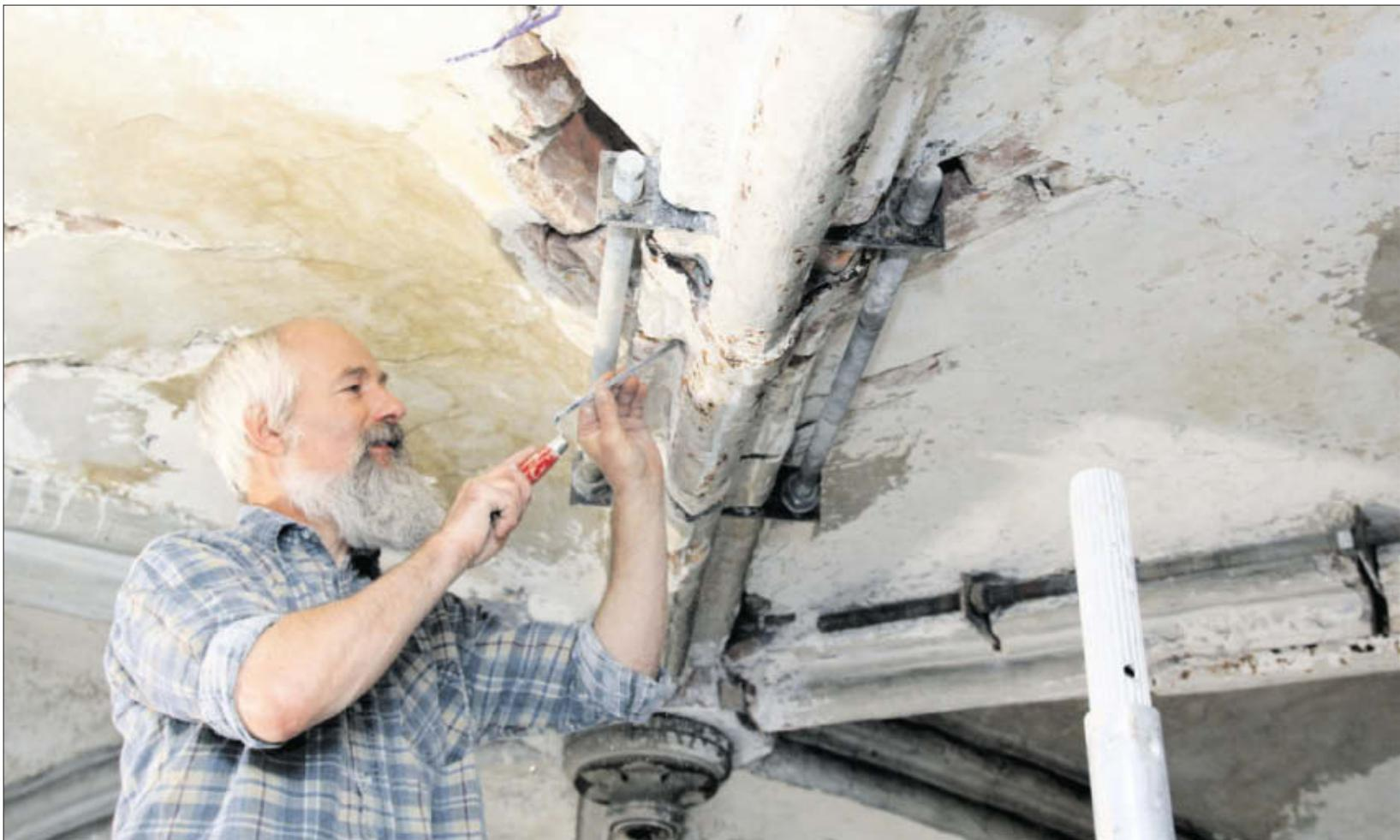
Mit Stahlankern überbrückt Restaurator Peter Wagner (54) die verrosteten mittelalterlichen Eisenkonstruktionen zum Ausbau. Fotos (2): Karsten Wilke
